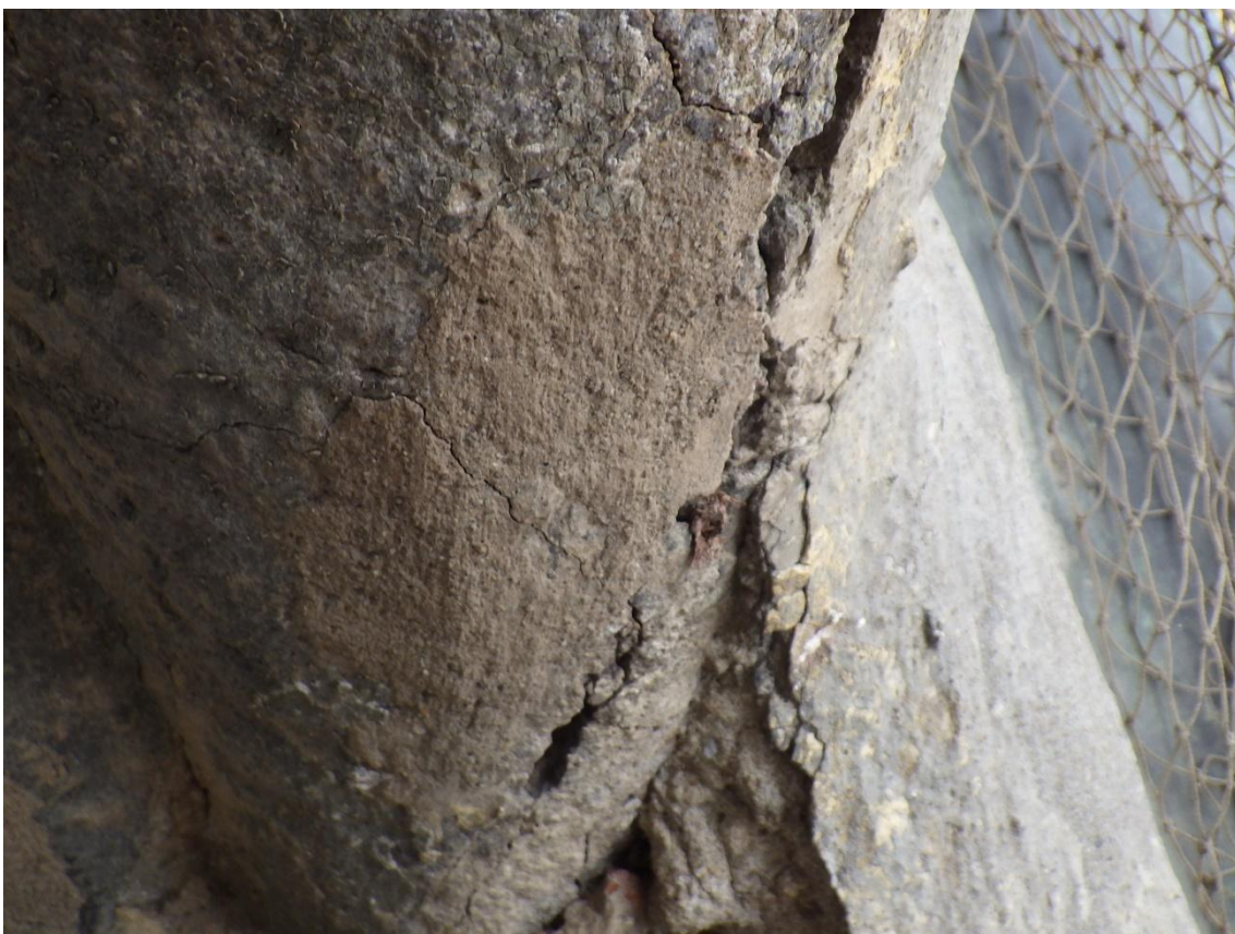
Trhliny a rozpad materiálu do hloubky
