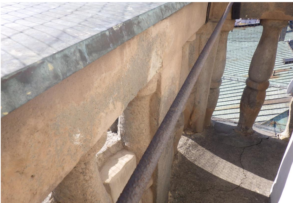
Betónová mazanina a dodatečně instalovaná táhla
