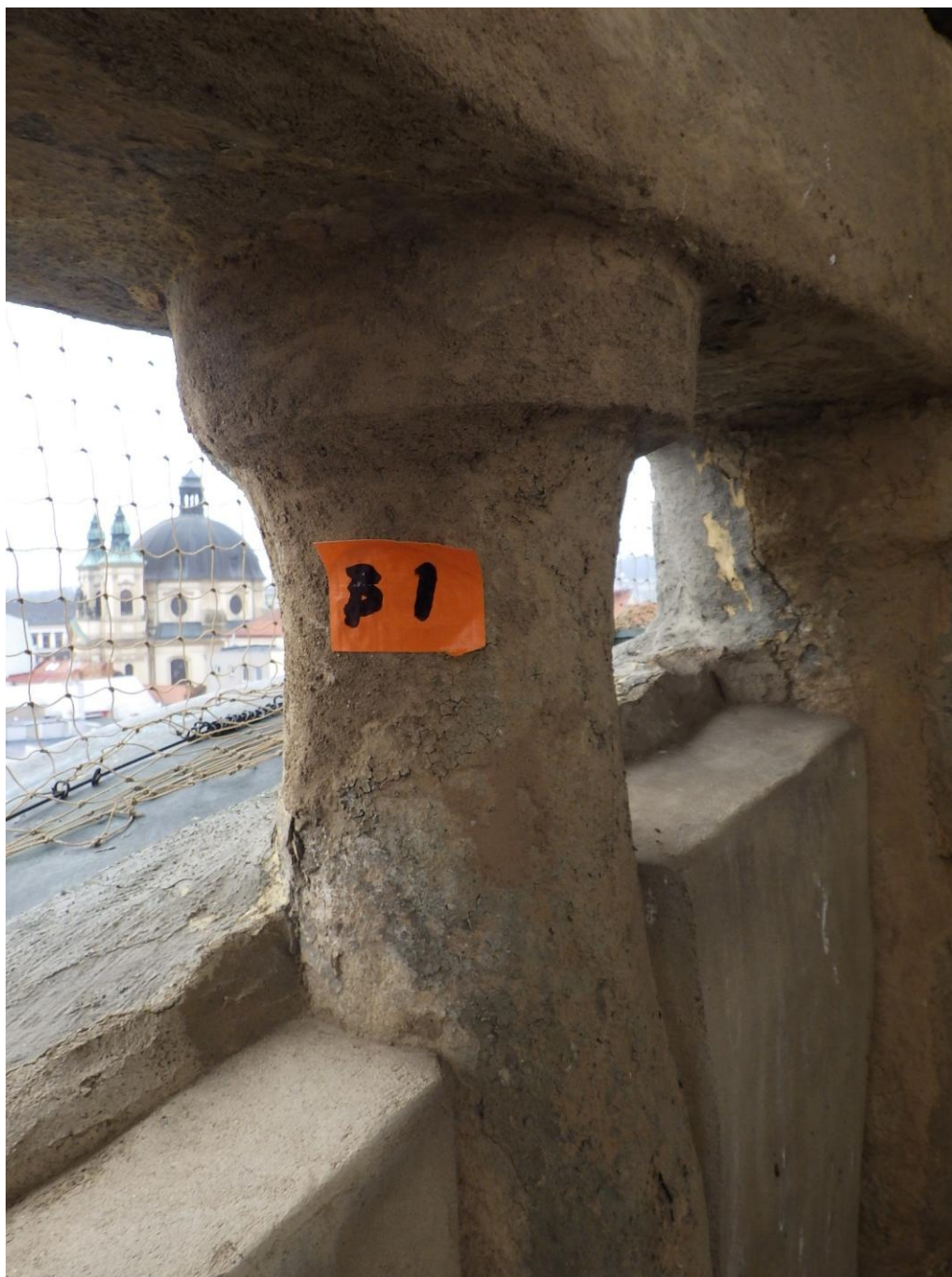
Odběr vzorku B1 pro stratigrafii
