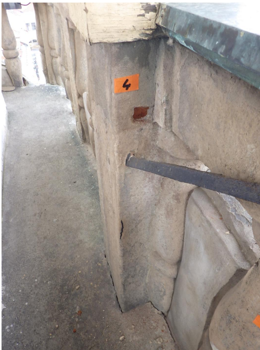
Vrchní část sloupku tvoří sádrová vyzdívka
